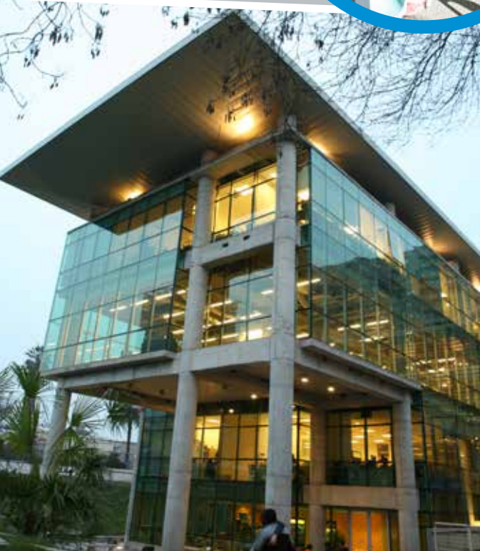
EDIFICIO TECNOAULAS CORPBANCA HALL
